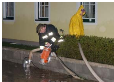
22.4.2008 – schwere Unwetter in Gföhl, Auspumparbeiten
