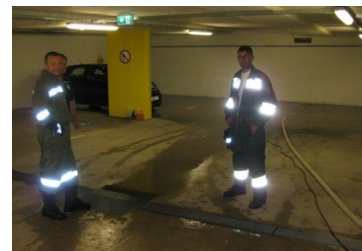
13.07.2016 – Auspumparbeit in Tiefgarage
